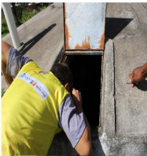
Inspeção de reservatório.
